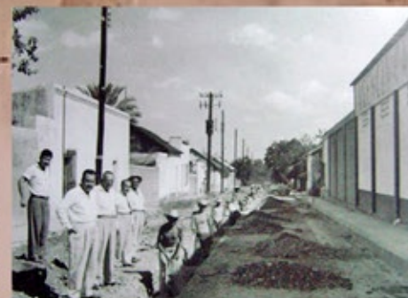
1957: Instalación del drenaje en Allende
