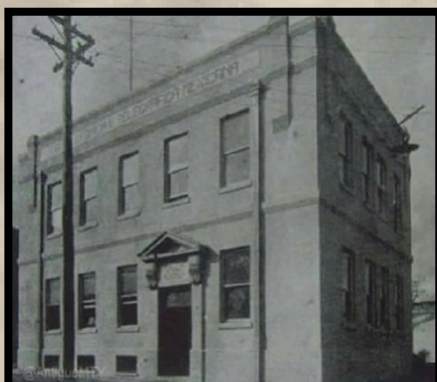
Edificio Telmex 5 de Mayo y Emiliano Carranza
