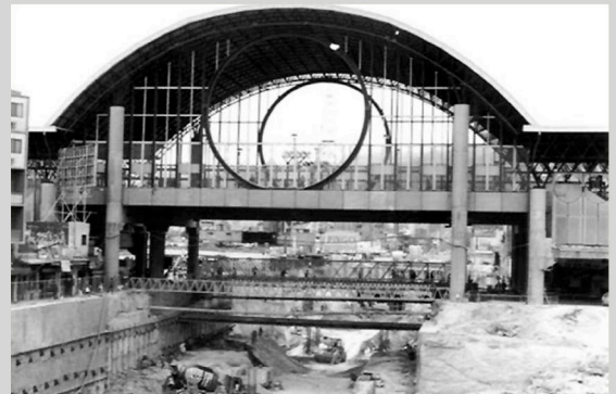
Obra de la estación Cuauhtémoc del metro Monterrey.
