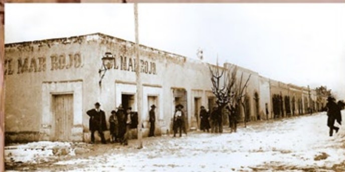
Calzada Madero año1898
